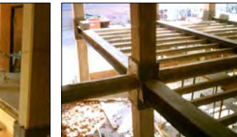
ACTUACIÓ: cobertura parcial del porxo per crear noves aules; treballs de muntatge de subestructura metàl·lica de reforç i nou forjat interior.
