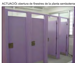
ACTUACIÓ: reforma de banys i acabats en general.
