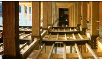
ACTUACIÓ: cobertura parcial del porxo per crear noves aules; treballs de muntatge de subestructura metàl·lica de reforç i nou forjat interior.
