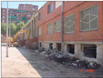
ACTUACIÓ: obertura de finestres i impermeabilització del mur.
