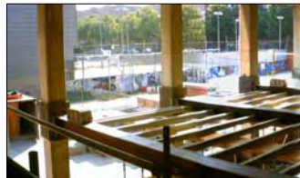
ACTUACIÓ: cobertura parcial del porxo per crear noves aules; treballs de muntatge de subestructura metàl·lica de reforç i nou forjat interior.
