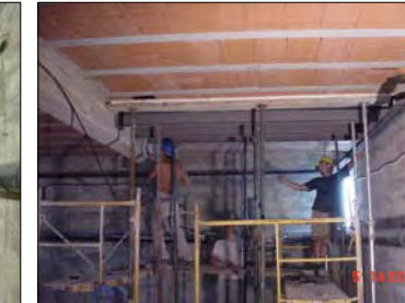
ACTUACIÓ: col·locació reforços metàl·lics.
