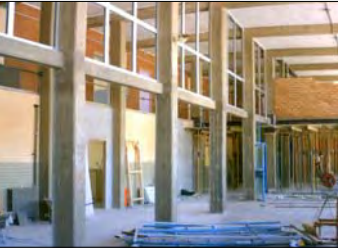
ACTUACIÓ: obertura de finestres i impermeabilització del mur.
