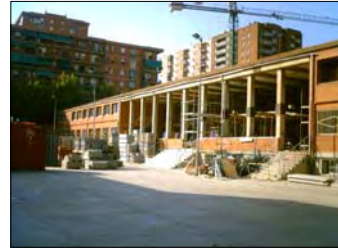
ACTUACIÓ: cobertura parcial del porxo per crear noves aules; substitució de fusteries de la porxo restant i millora d'acabats.
